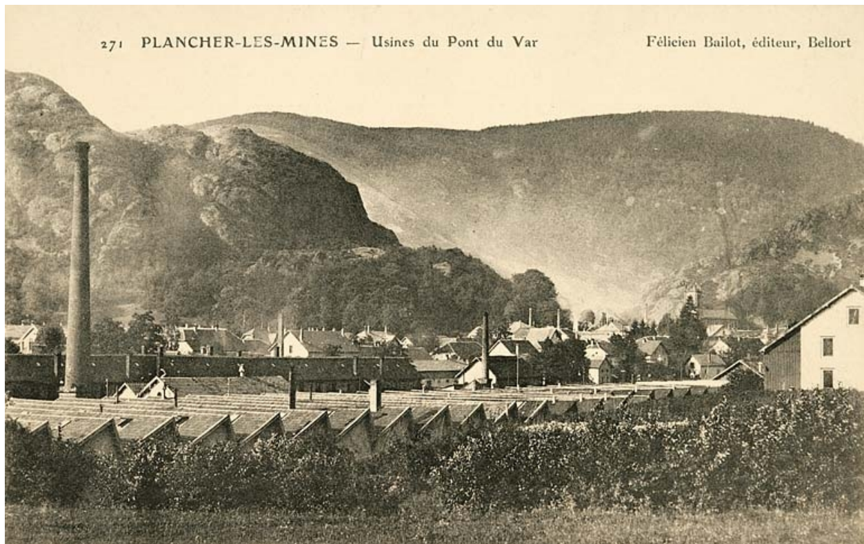
Plancher-les-Mines - Usines de Pont du Var.
