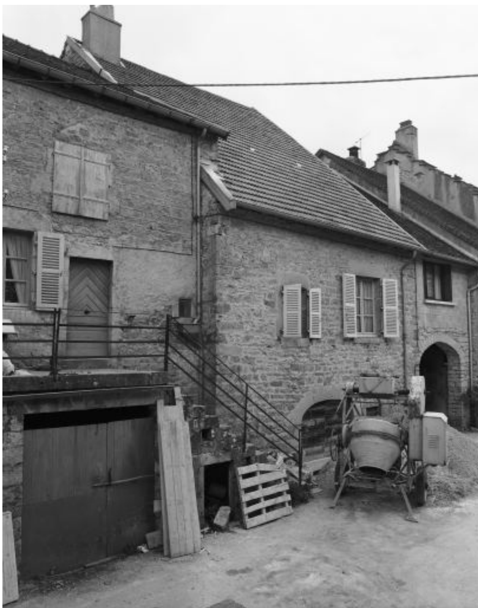
Façade sur l'impasse du Quart d'Amont.
