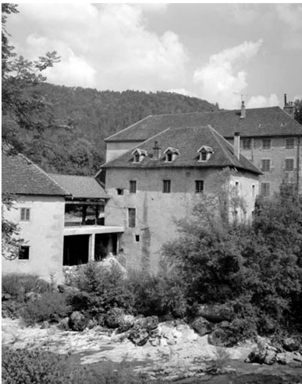
Moulin : façade latérale gauche.
