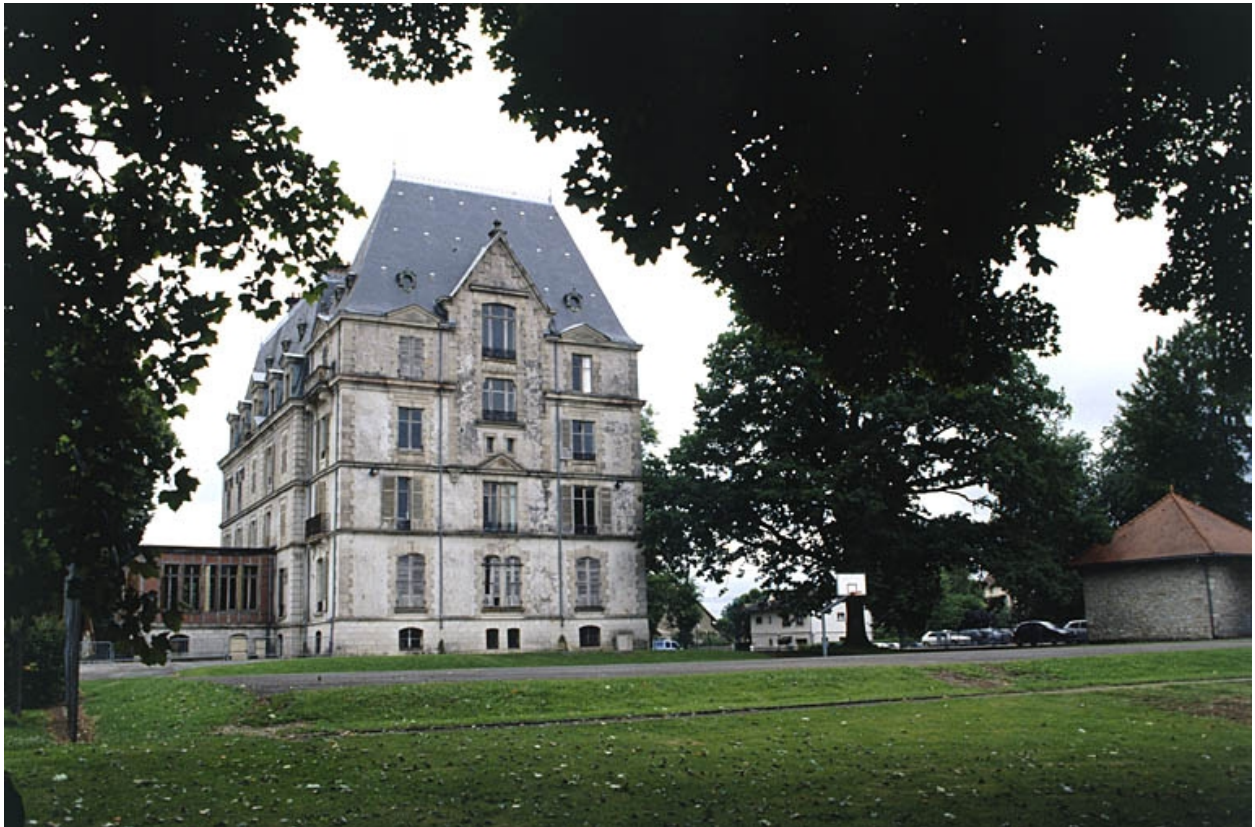
Façade ouest vue de trois quarts gauche.
