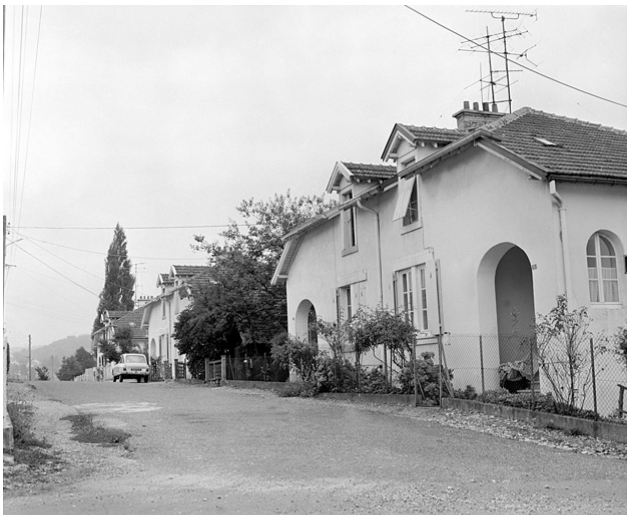
Rue des Fondateurs : cité ouvrière Adolphe Japy.
