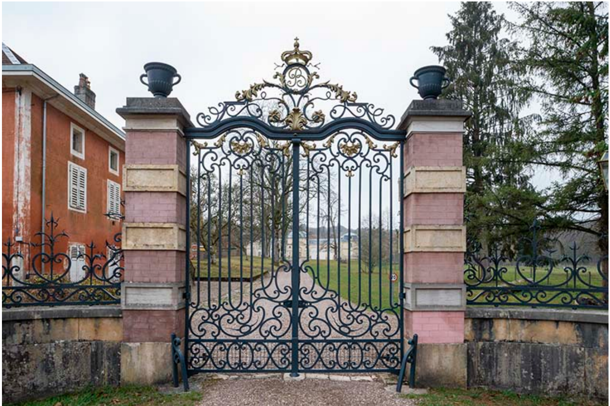
Clôture (grille) sur la rue de Saint-Albin.
