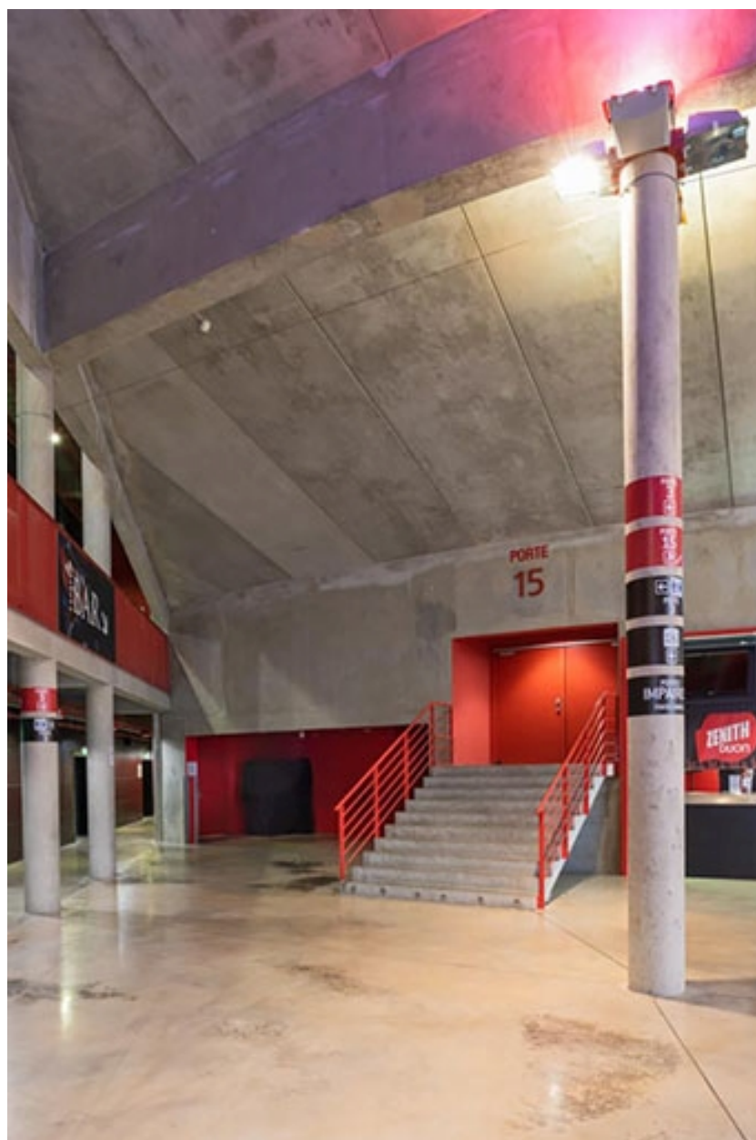
Vestibule : dessous des gradins et porte 15.
