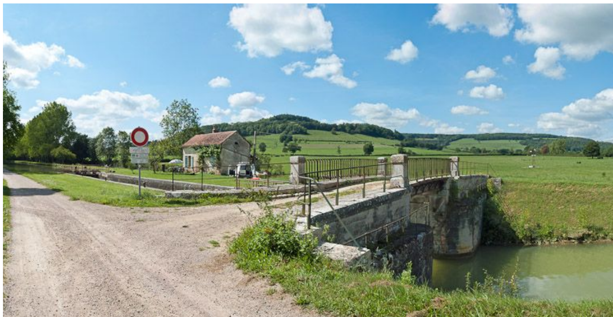
Vue d'ensemble du site d'écluse.
