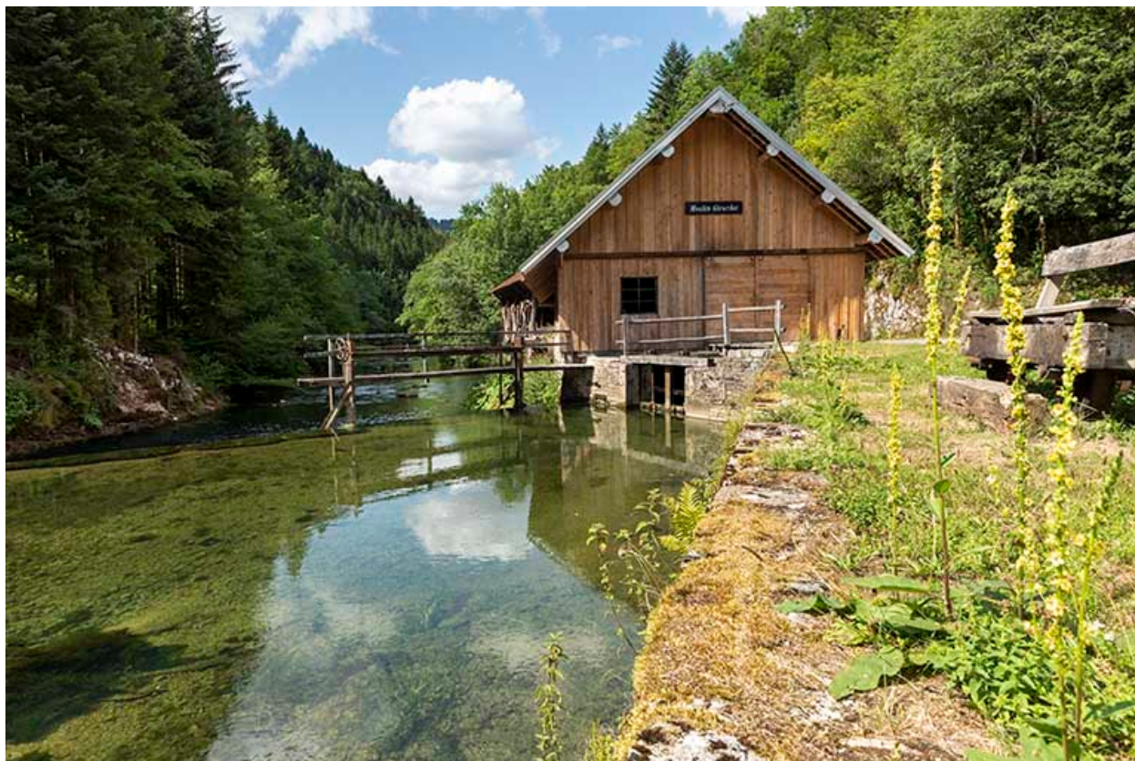
Scierie, depuis l'amont (sud) : vue rapprochée.
