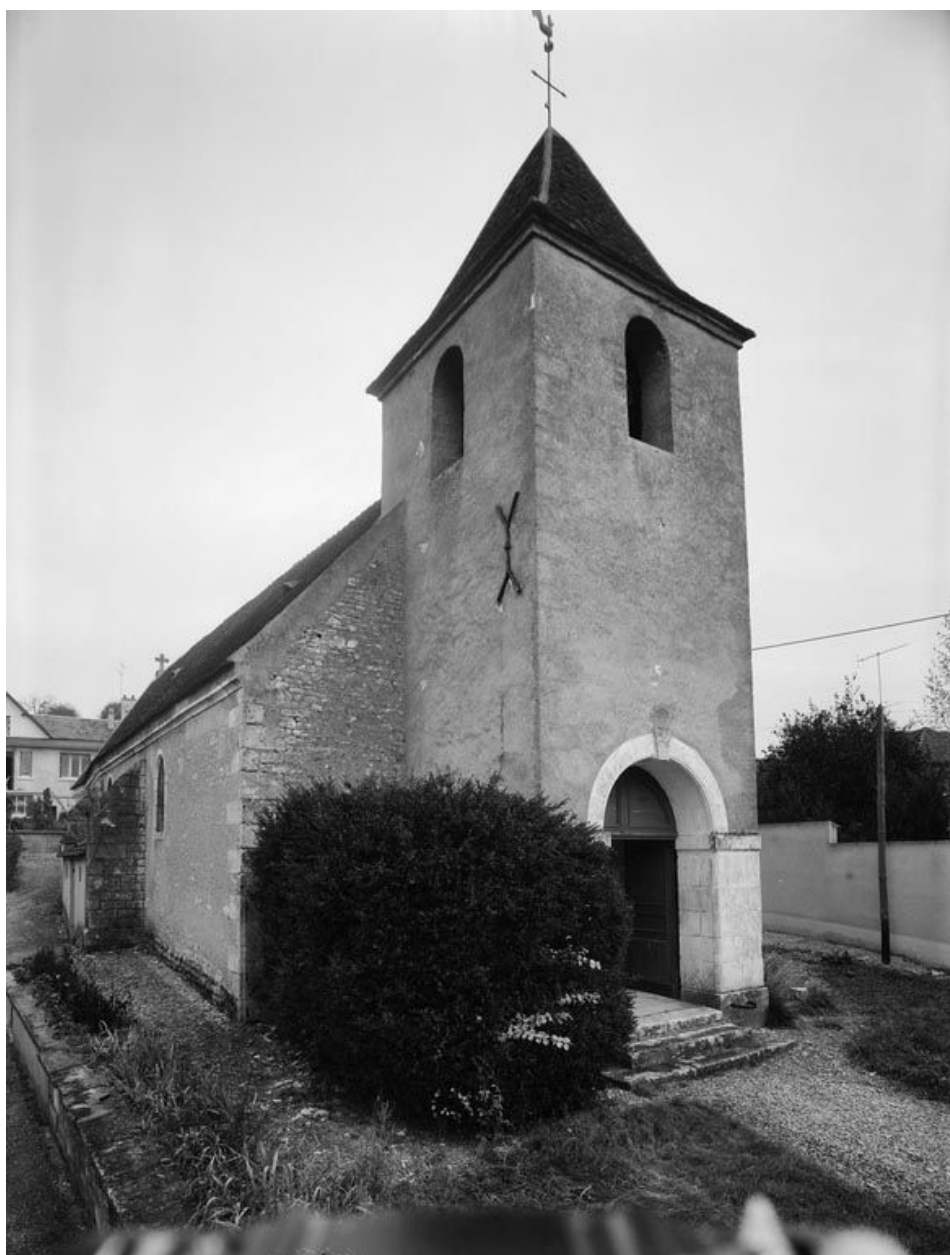
Façade antérieure et élévation gauche.
