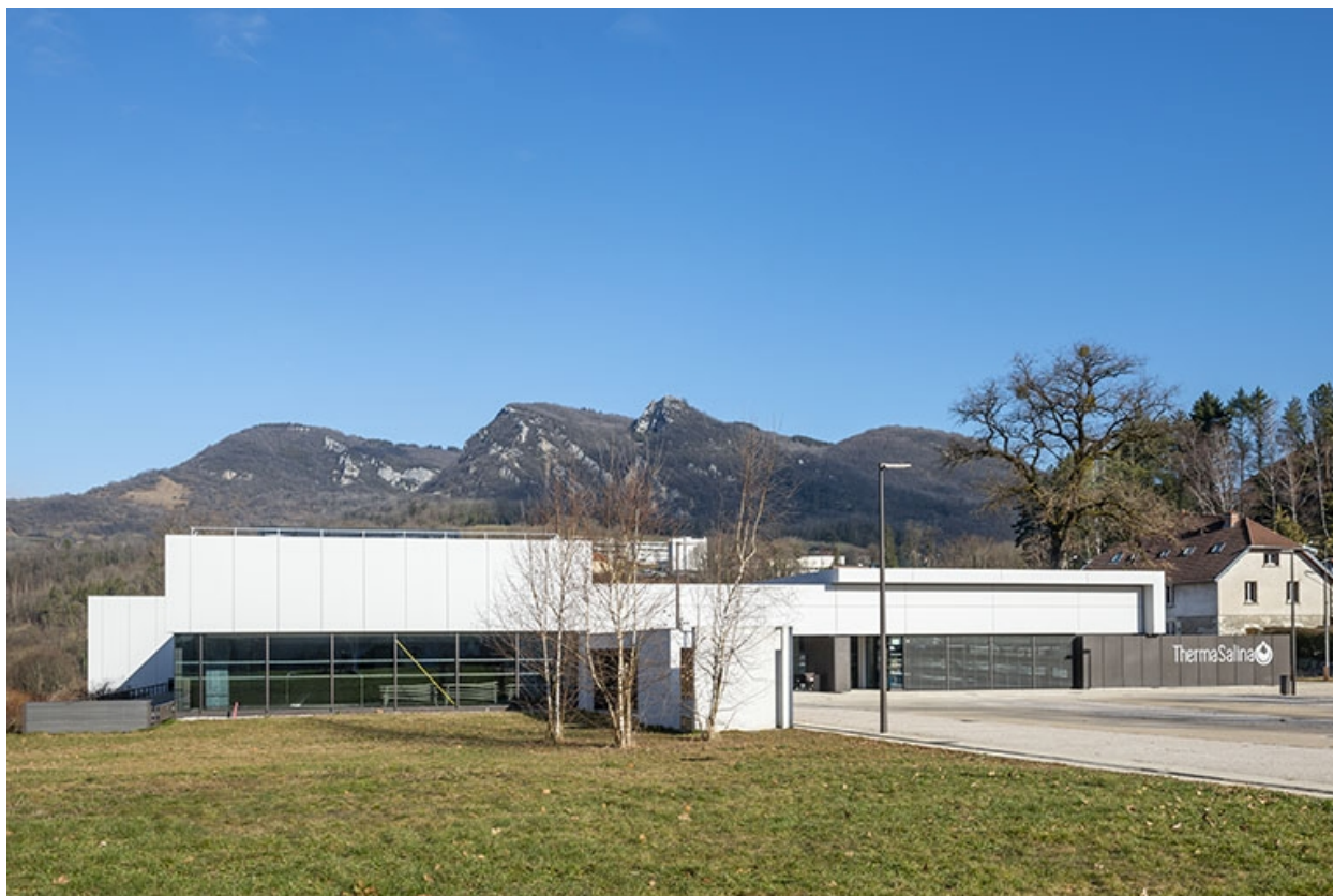
Vue depuis le sud.
