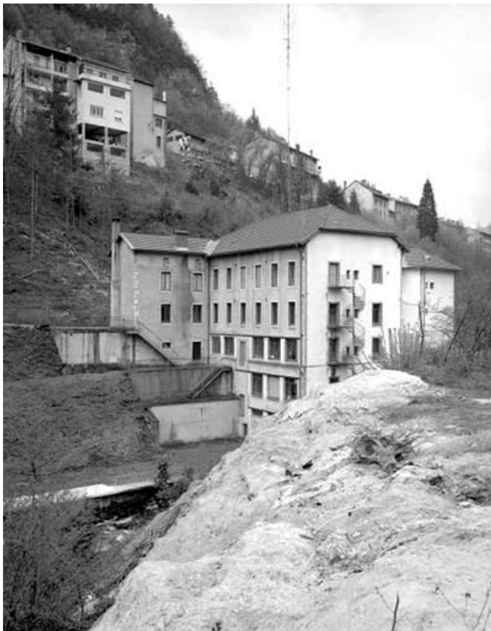
Ateliers de fabrication depuis le nord.
