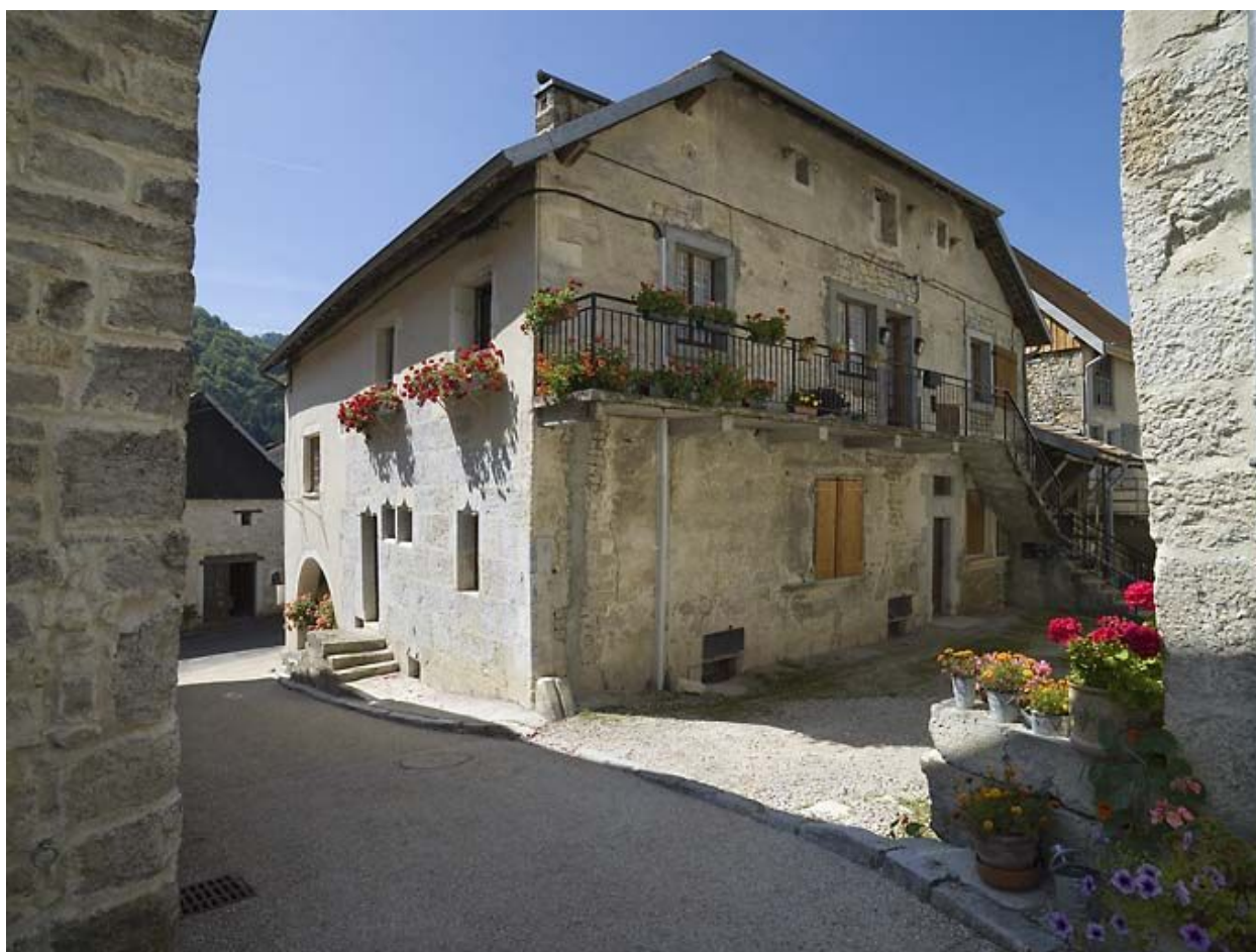
Façades antérieure et latérale droite.
