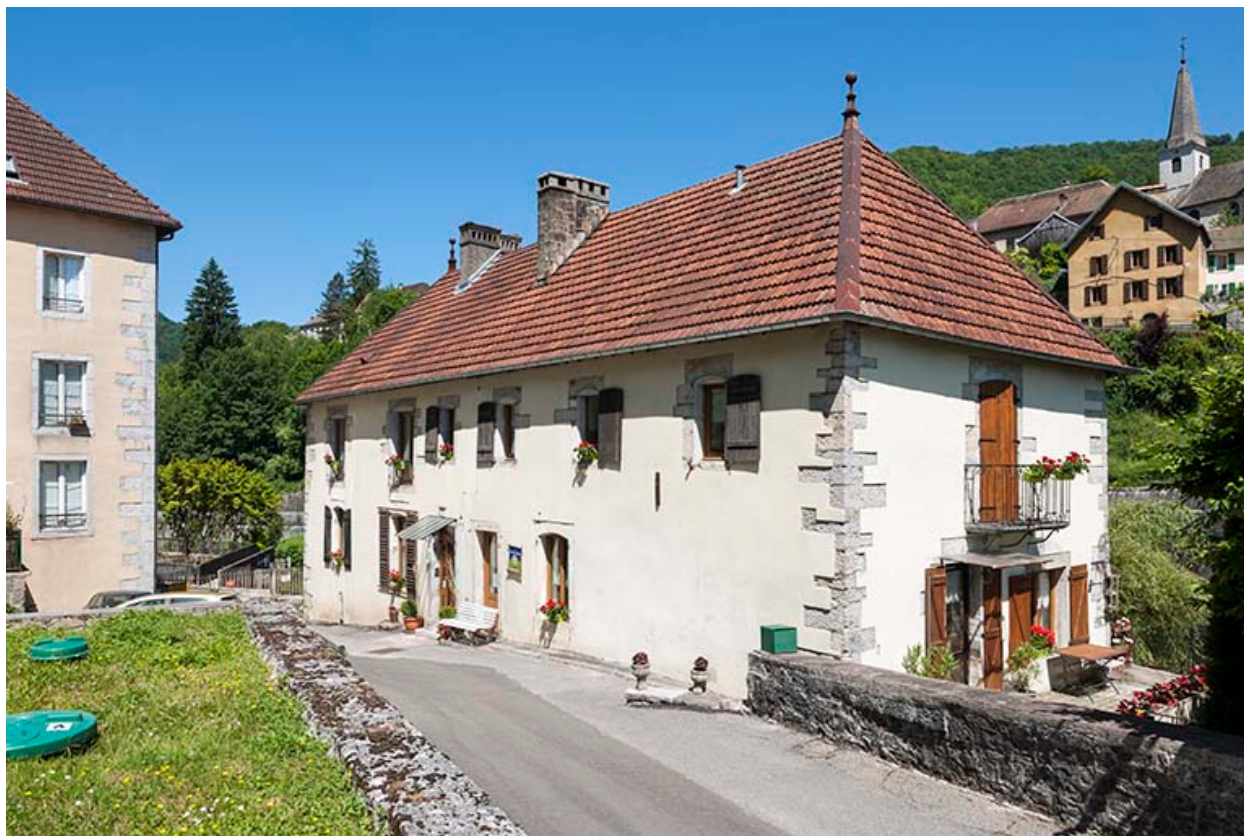
Logement d'ouvriers vue de trois quarts.
