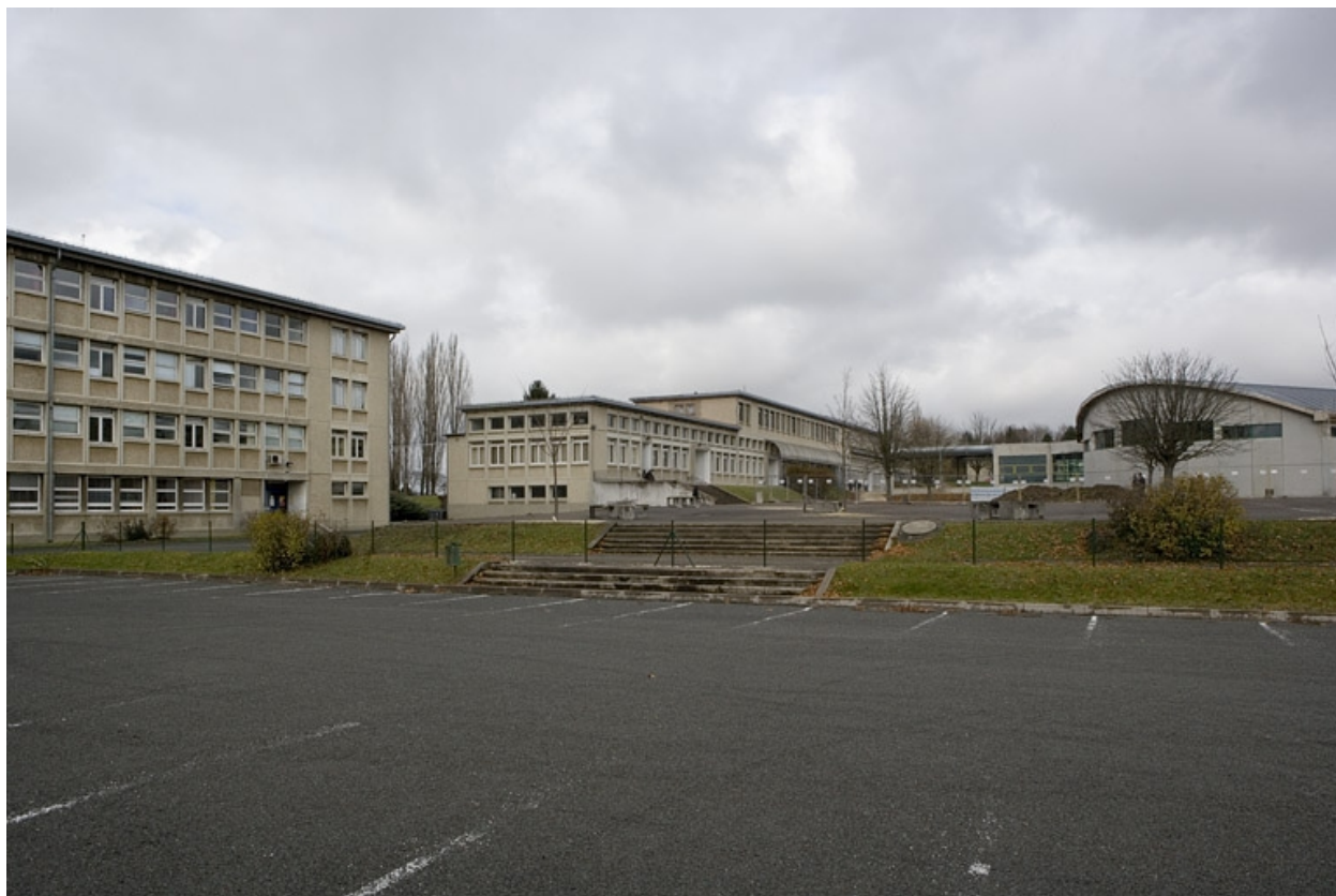
Vue d'ensemble bâtiments D et B.
