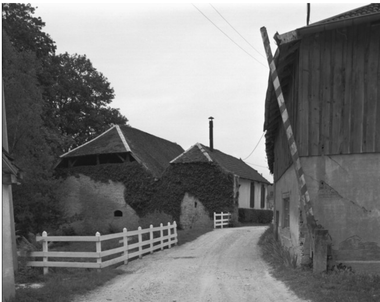
Halle à charbon sud depuis l'entrée en 1989.
