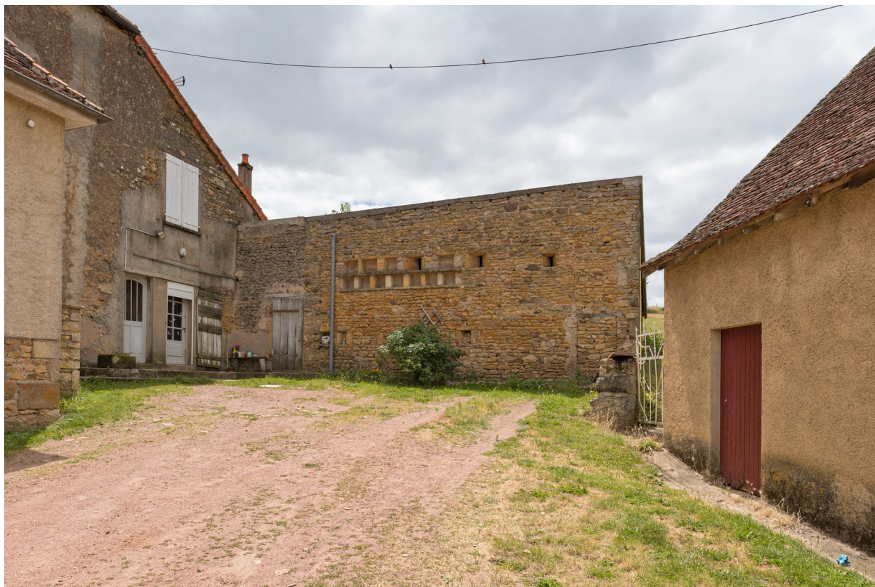
Mur d'une dépendance agricole (soue).
