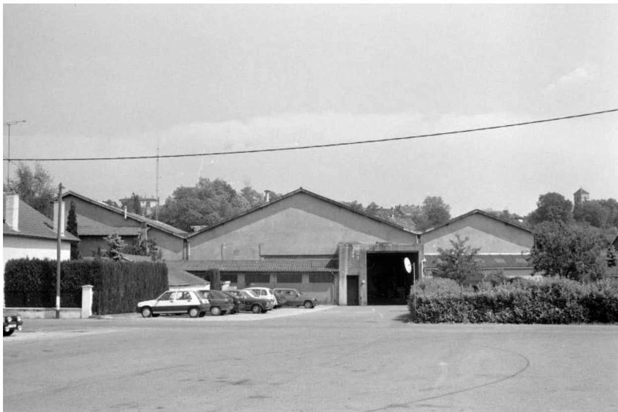
Façade postérieure vue de l'ouest.
