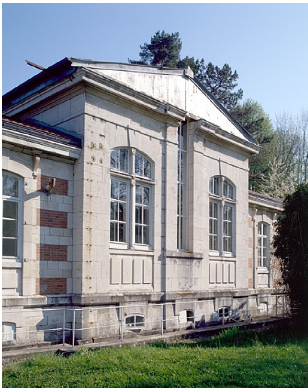
Façade sud, de trois quarts gauche.
