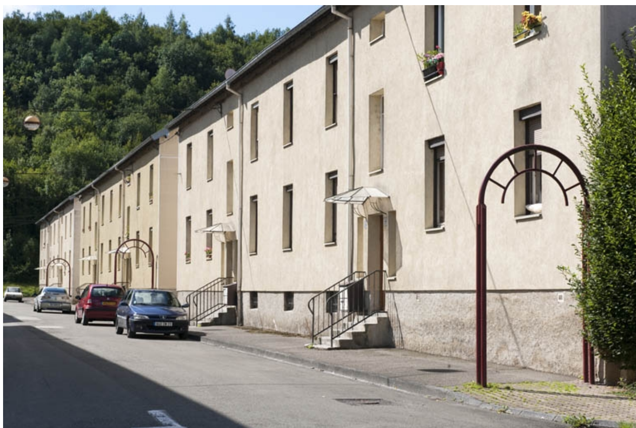
Façade antérieure des habitations.
