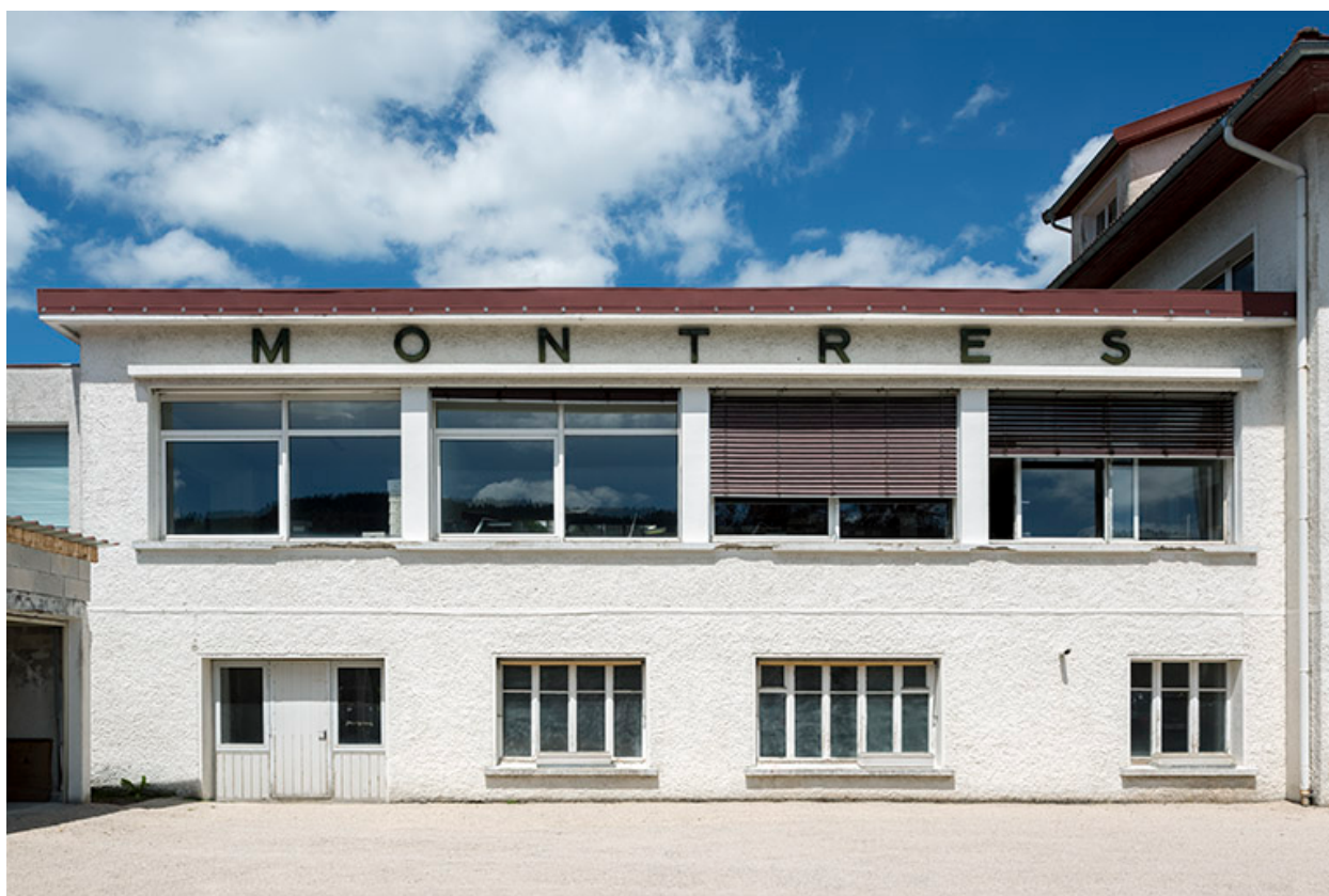
Façade antérieure de l'usine.
