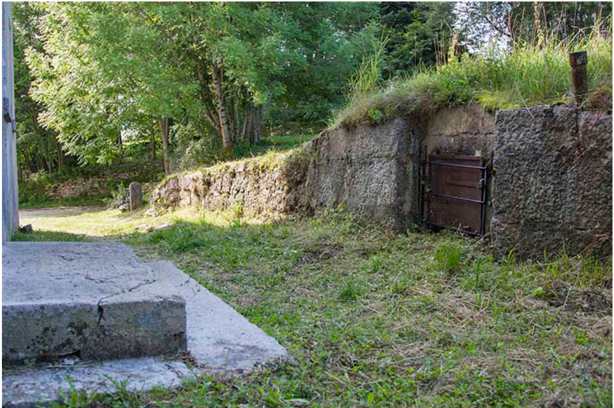
Citerne près de la façade postérieure.
