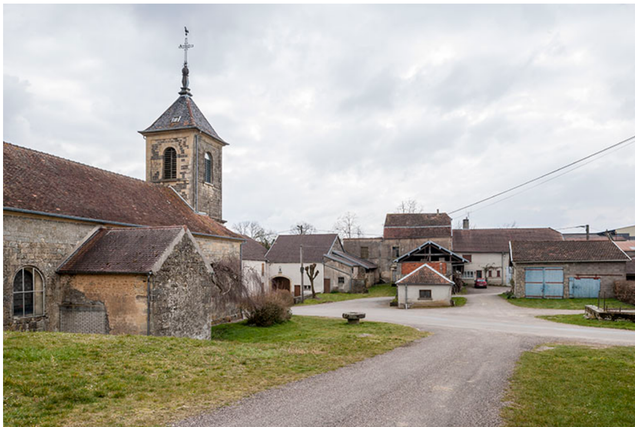
Vue sur le centre du village.
