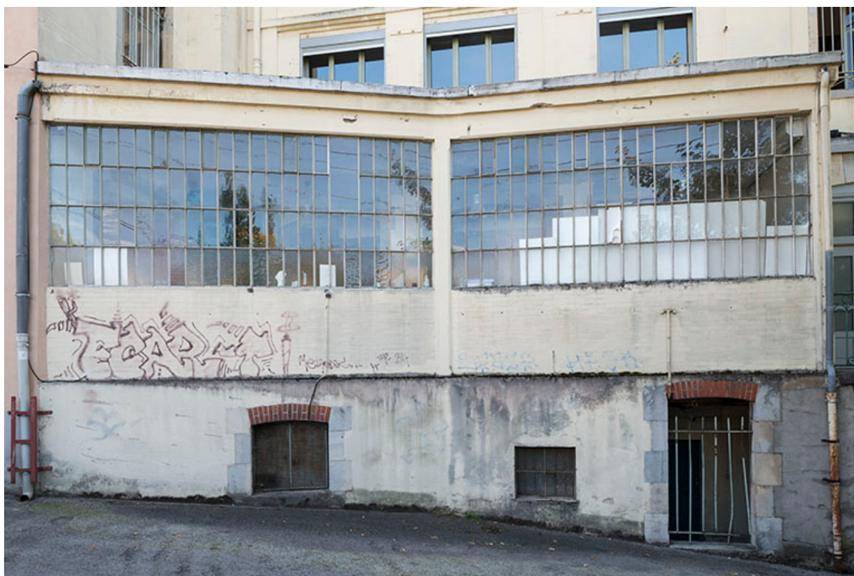
Verrière nord d'un atelier.
