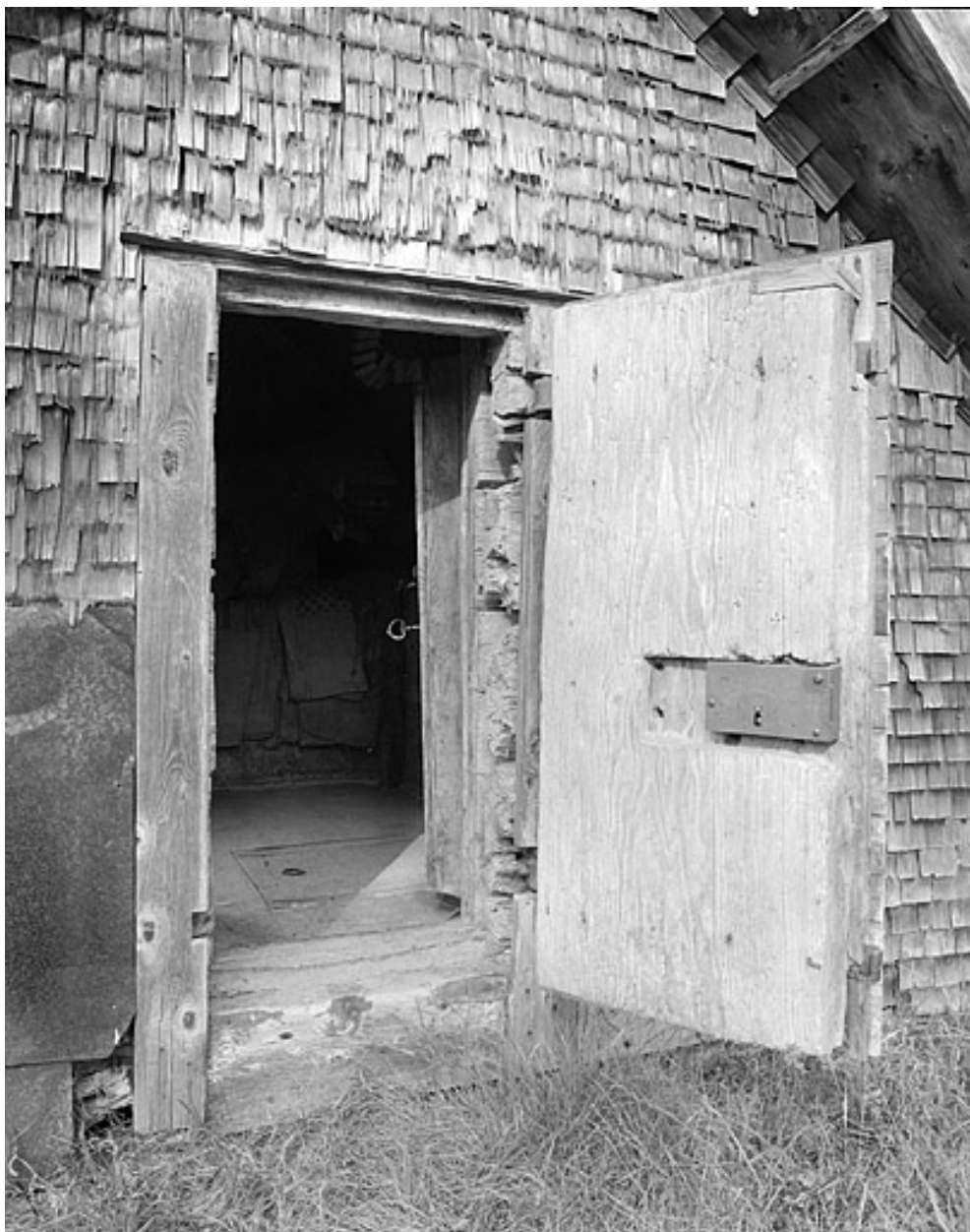
Les deux portes du grenier fort ouvertes.
