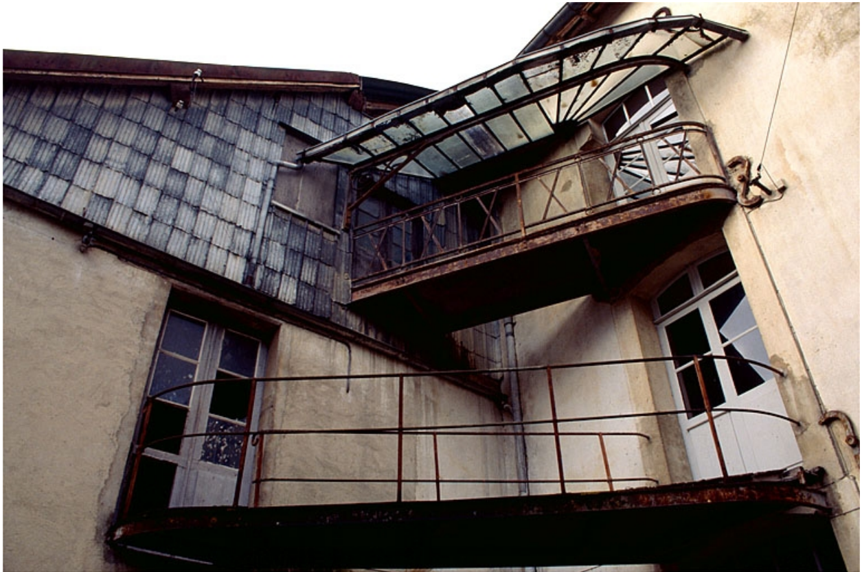
Ateliers de fabrication.Détail des passerelles.
