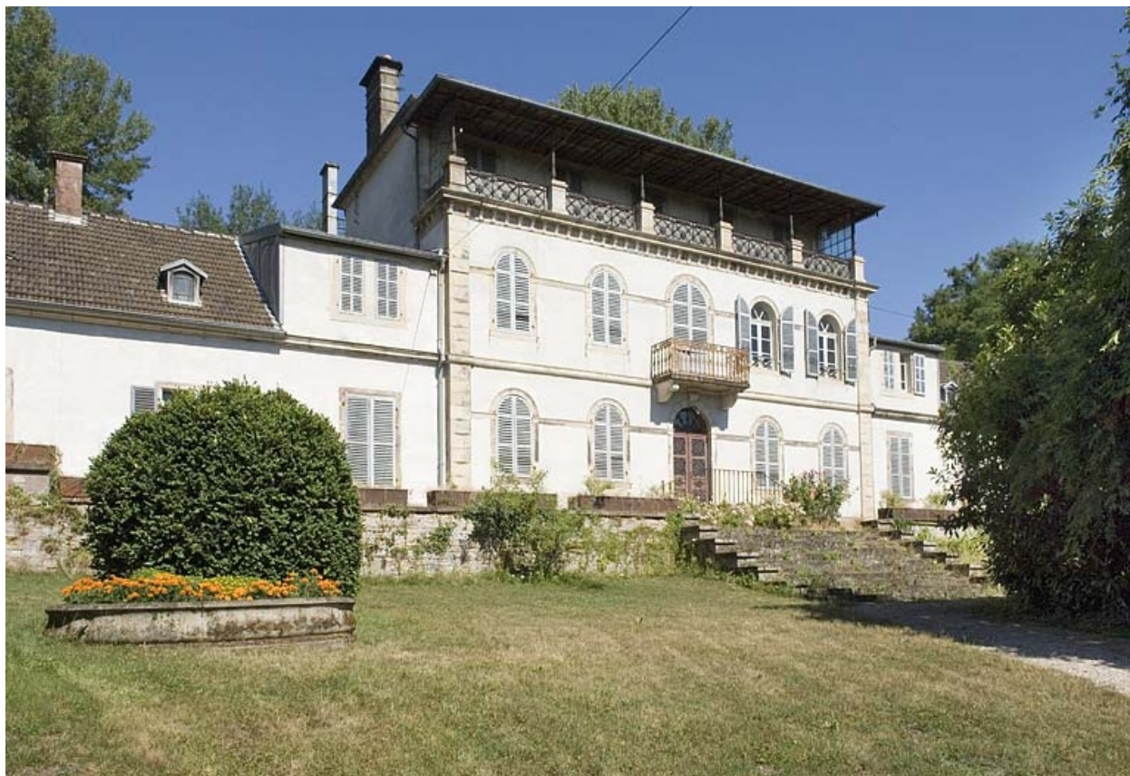
Logement patronal nord. Façade antérieure.
