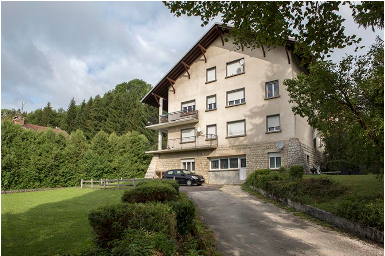
Maison : façade postérieure, de trois quarts droite.
