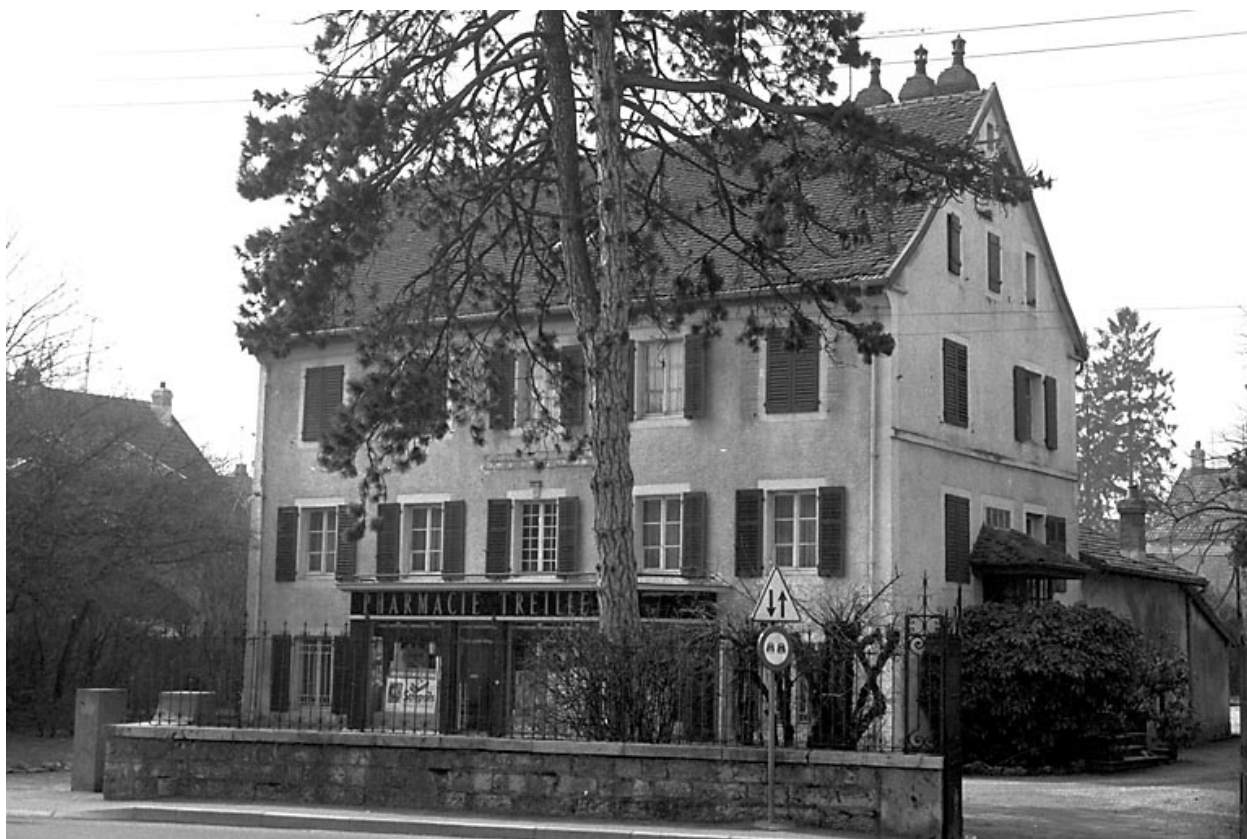
Façades antérieure et latérale droite.
