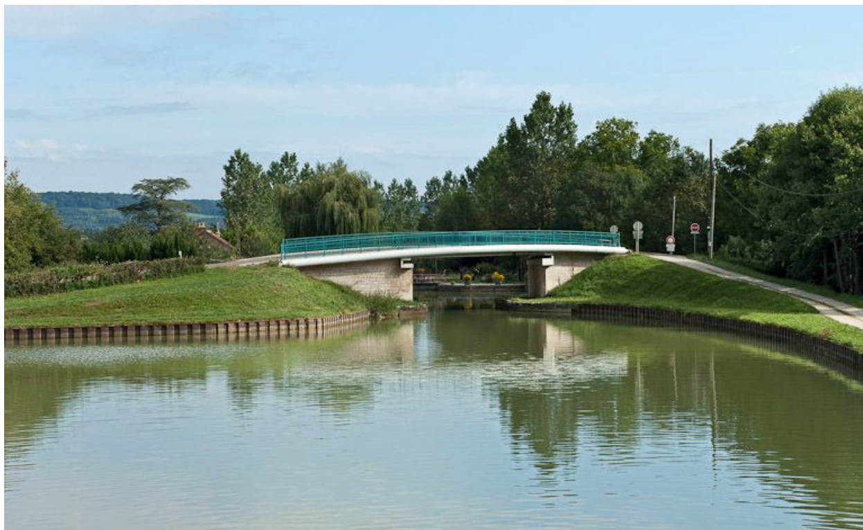
Vue du pont.
