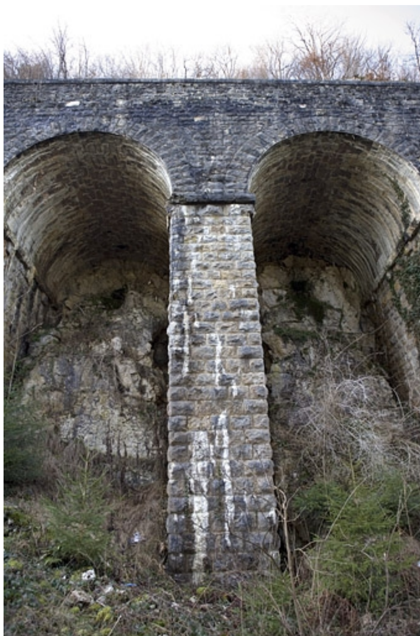
Deuxième mur à arcades : deux arches.
