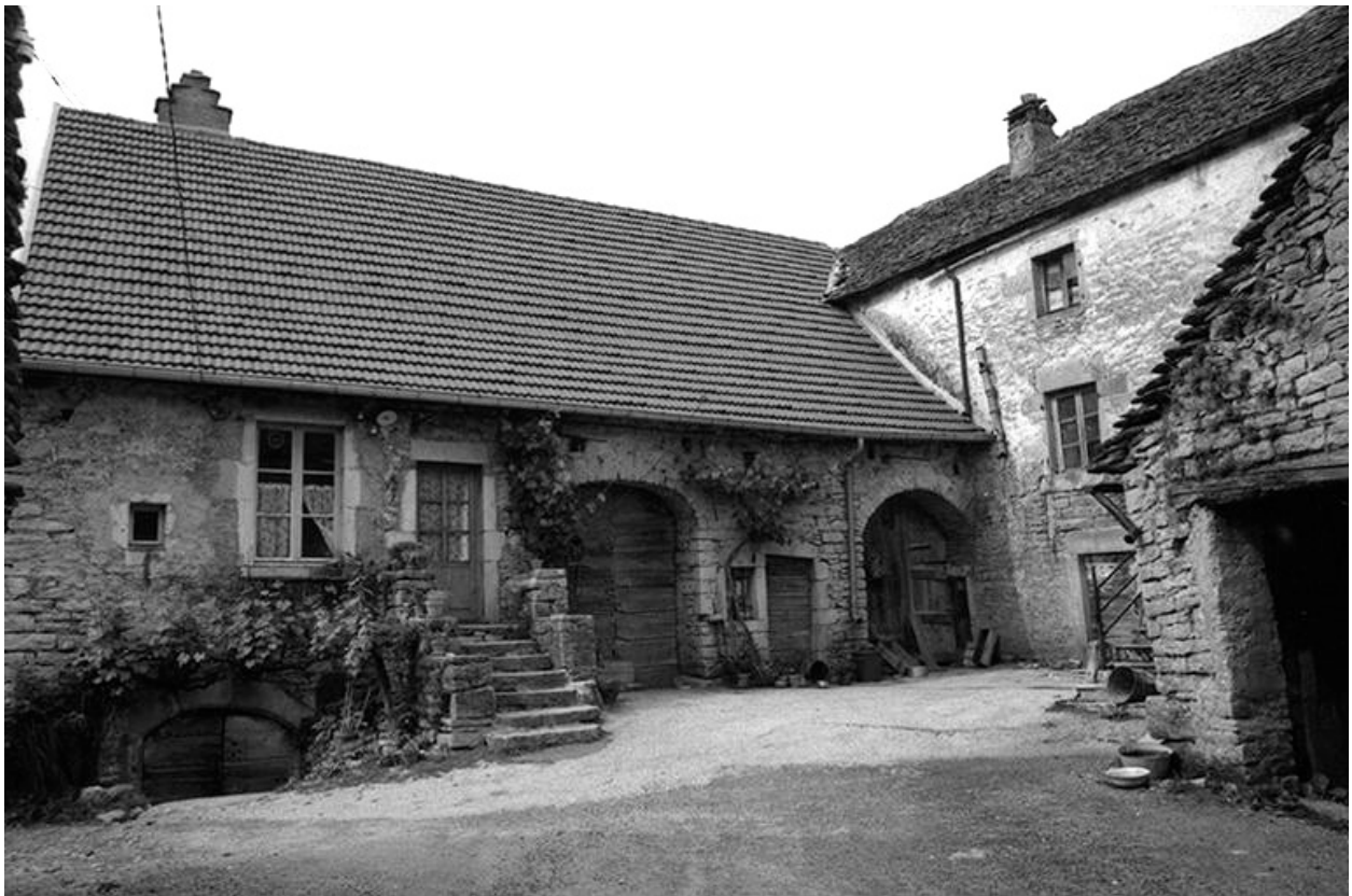
Façade antérieure en 1974. A noter le pignon à redents du bâtiment agricole.
