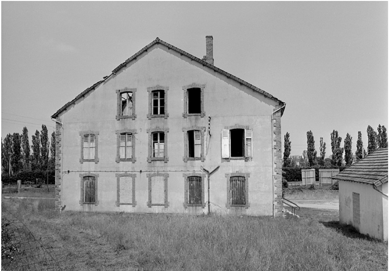
Façade postérieure du logement patronal et bureau.
