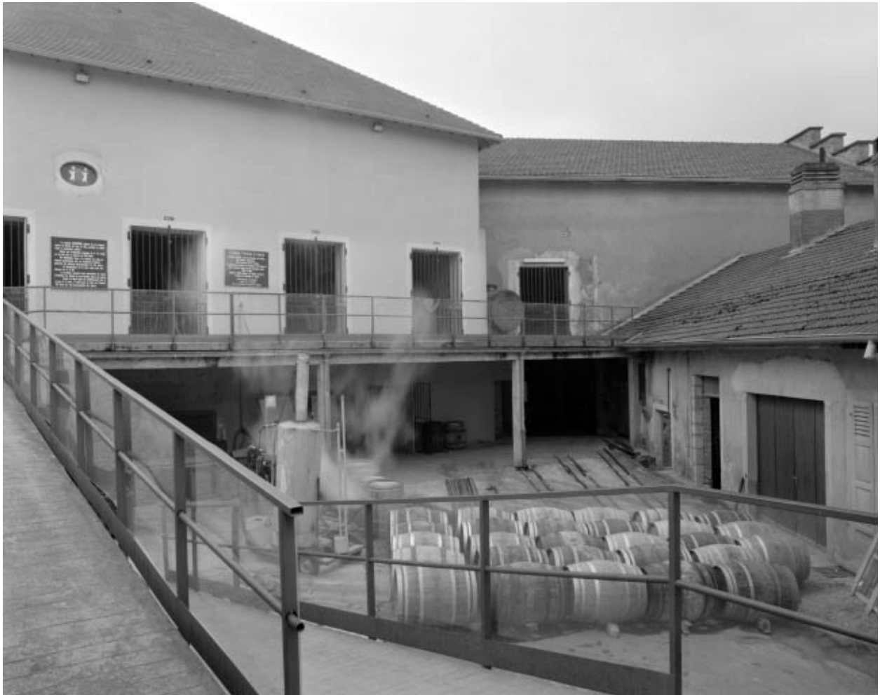
Façades sur cour des chais. Au centre de la cour : fûts de vieillissement du vin jaune.
