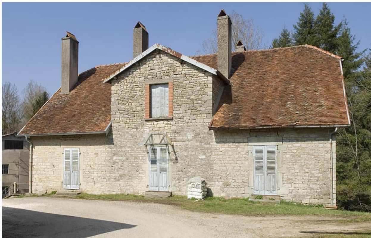
Façade sud du logement ouvrier.
