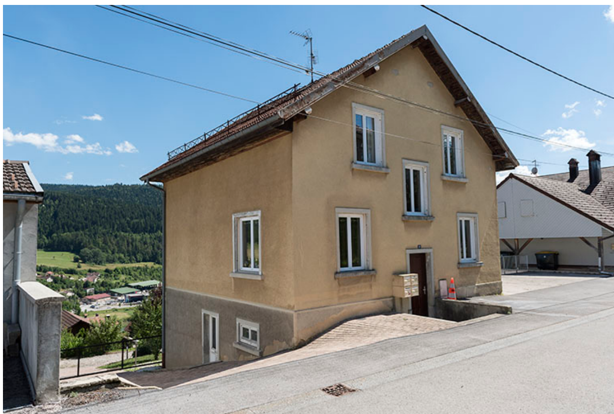
Façades antérieure et latérale gauche.
