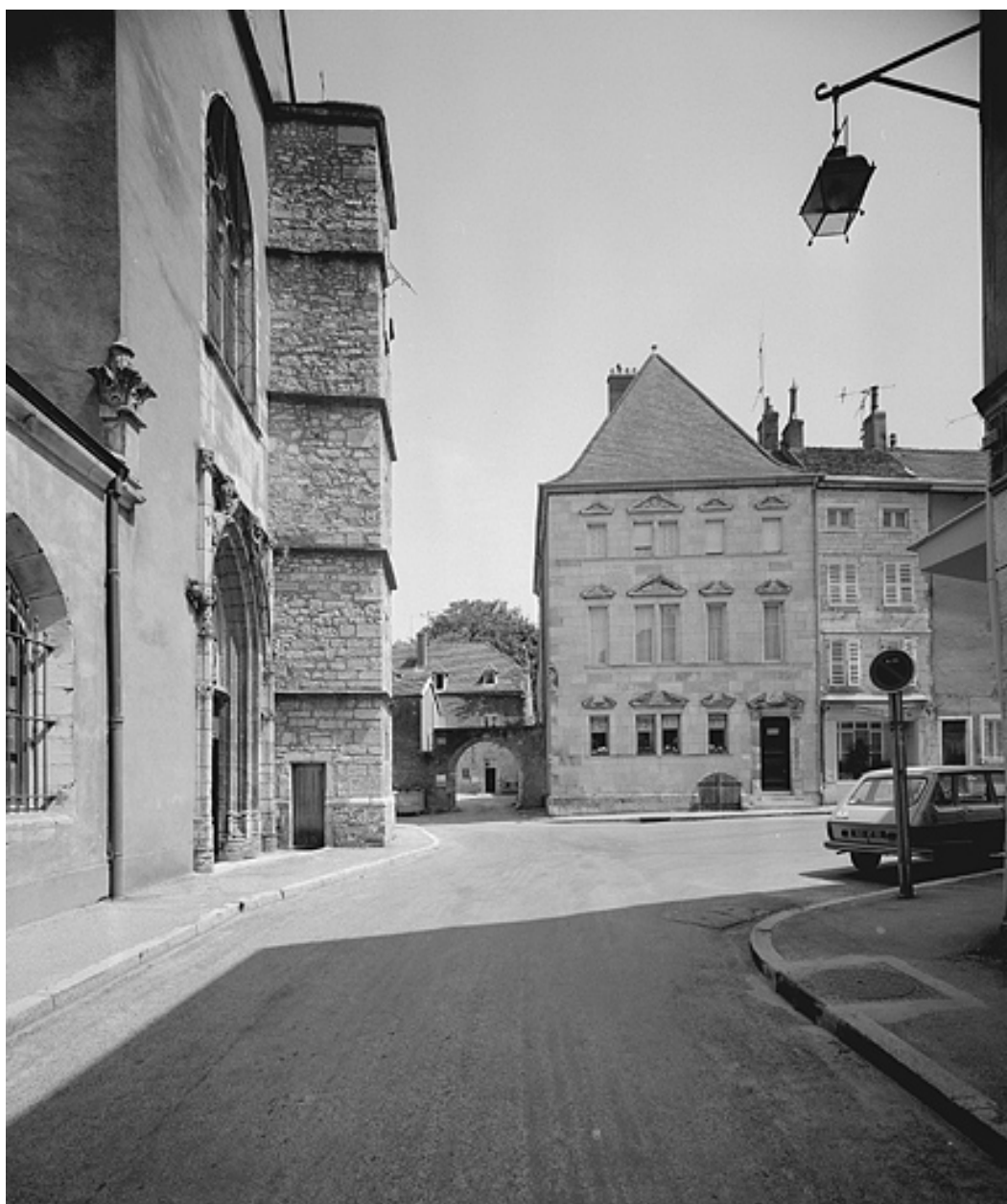
maison Paguelle de Larret située 12 rue de l'Eglise.
