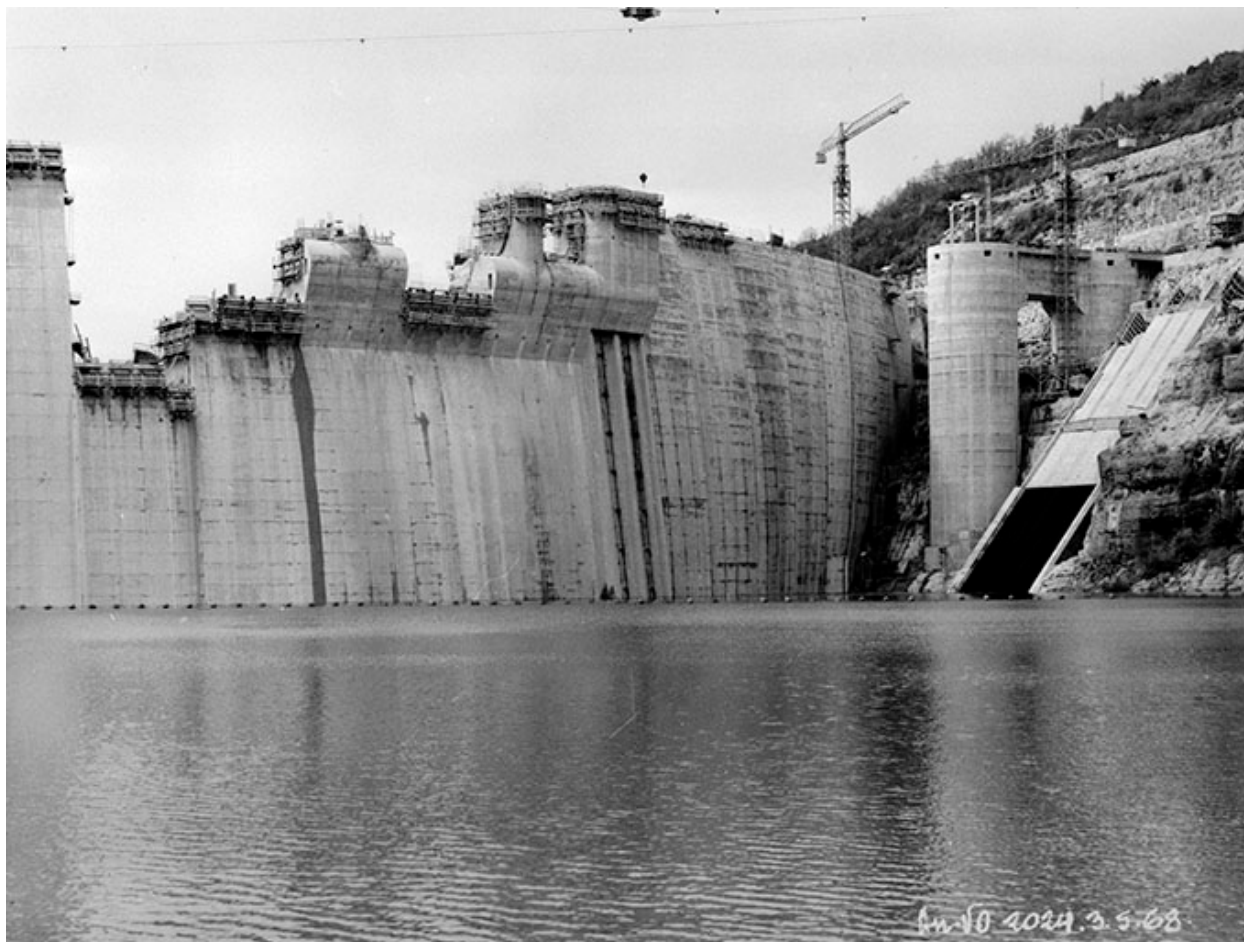
Barrage - Vue amont déversoir et prise d'eau.
