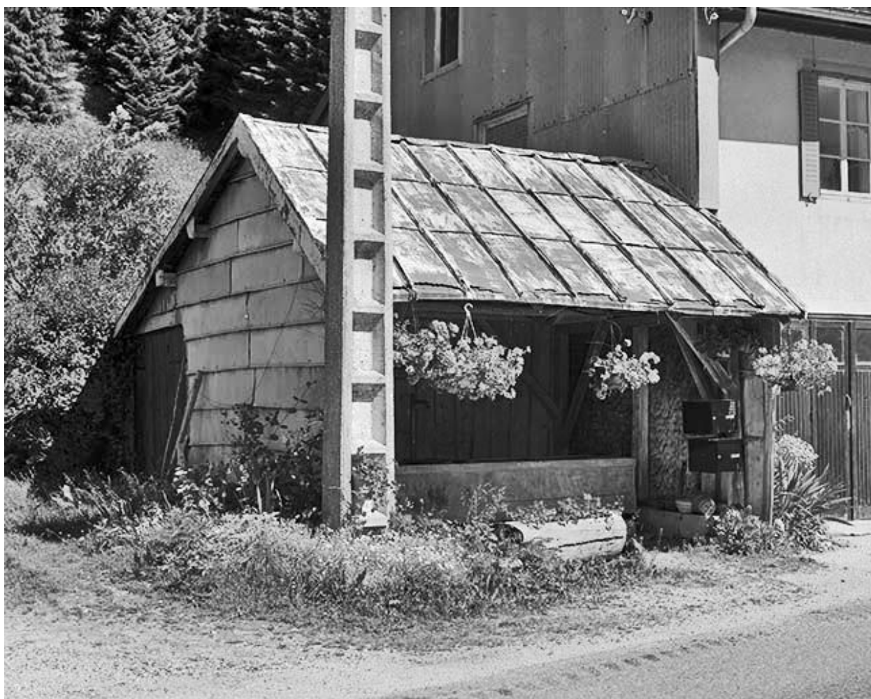
Vue depuis le sud-ouest.
