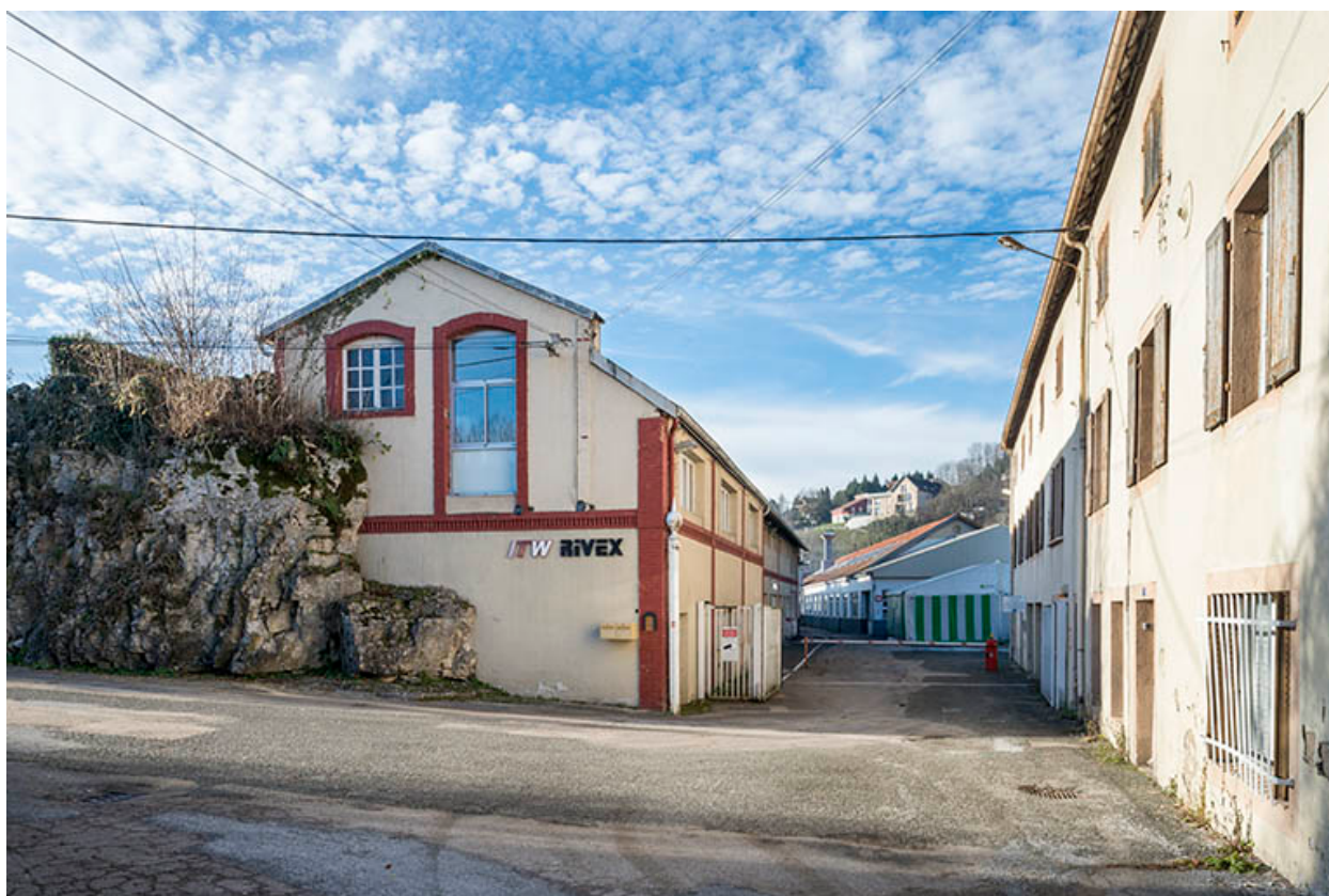
Vue d'ensemble depuis l'ancienne entrée (à l'est).
