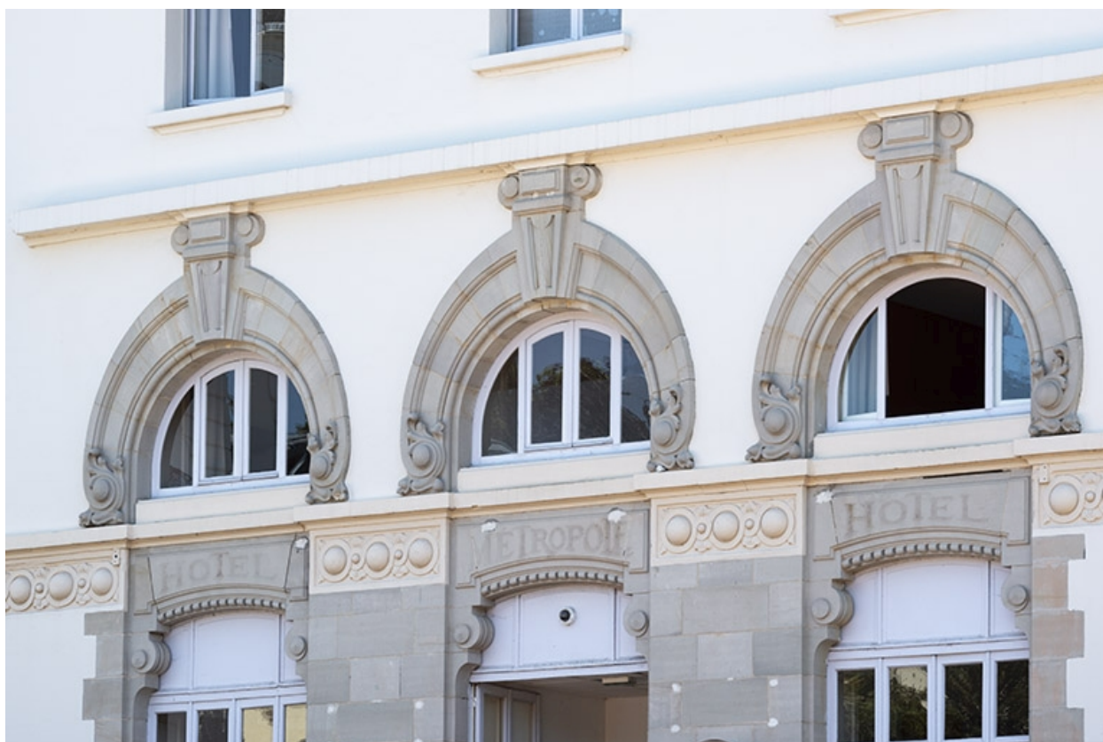
Façade nord, vue de trois quarts, détail.
