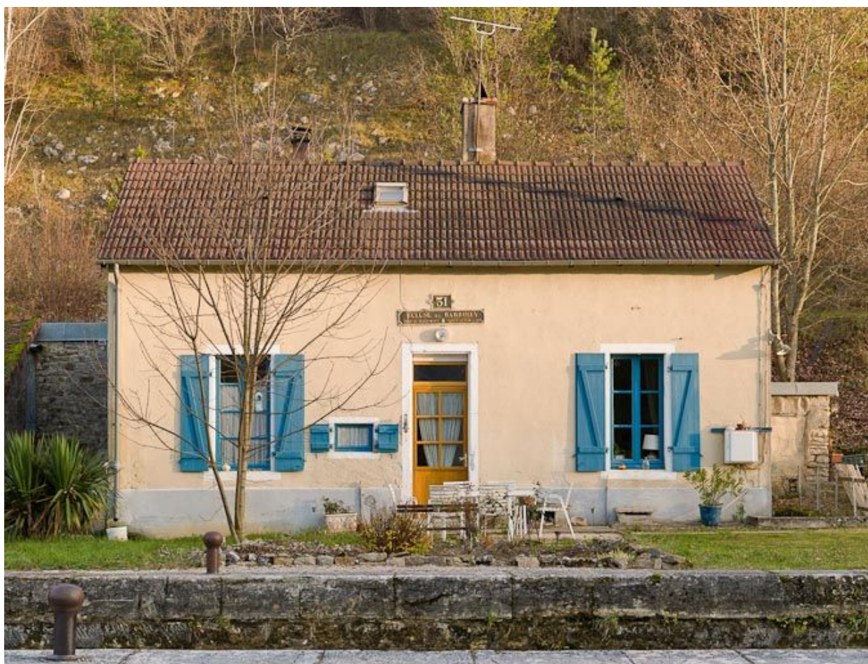
Vue de face de la maison éclusière.
