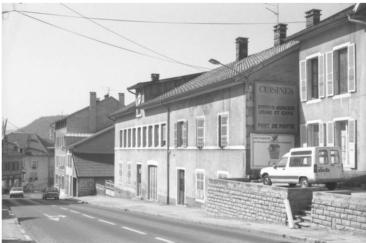
Vue d'ensemble de la façade antérieure.
