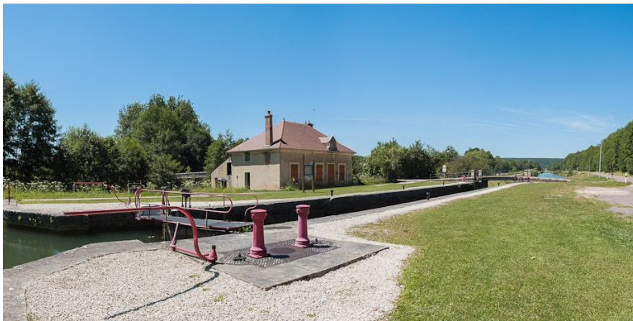
Le site d'écluse vu d'amont.
