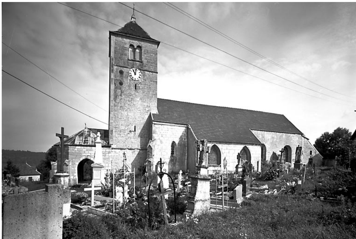
Façade latérale droite.
