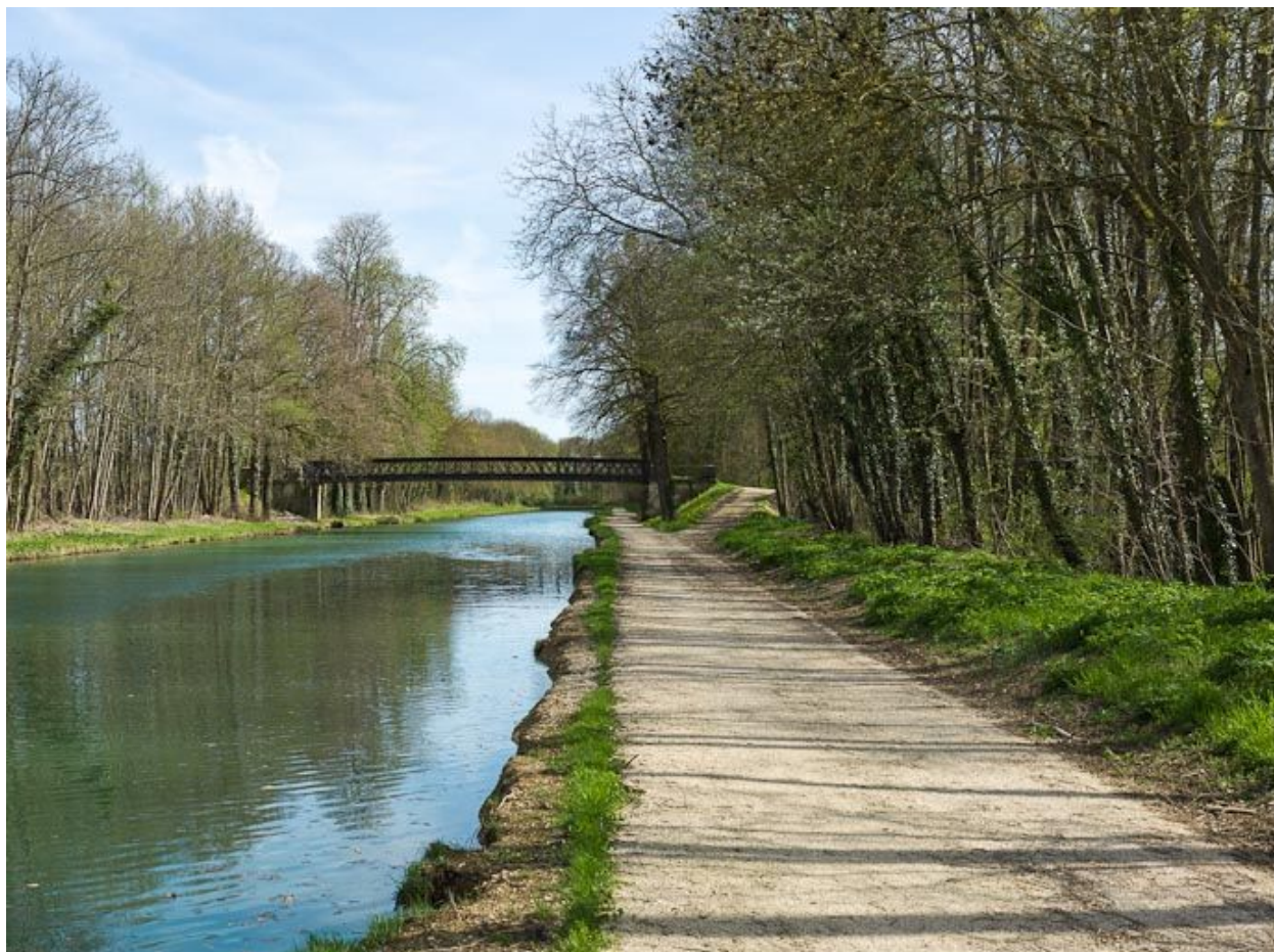
Vue d'ensemble du pont.
