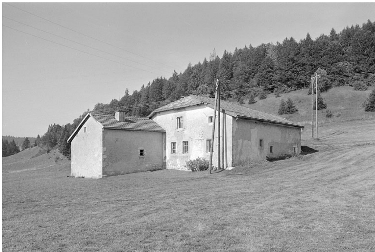
Face sud-est et façade postérieure.
