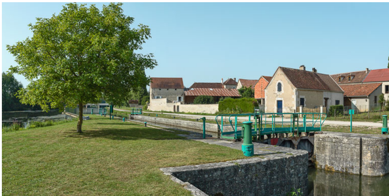
Vue du site d'écluse.
