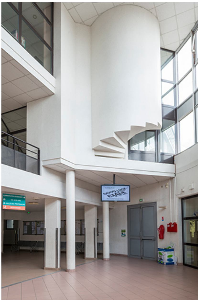
Détail intérieur de l'entrée.
