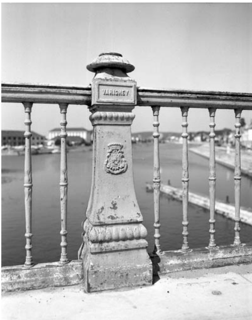
Détail du garde-corps : vue du balustre central.
